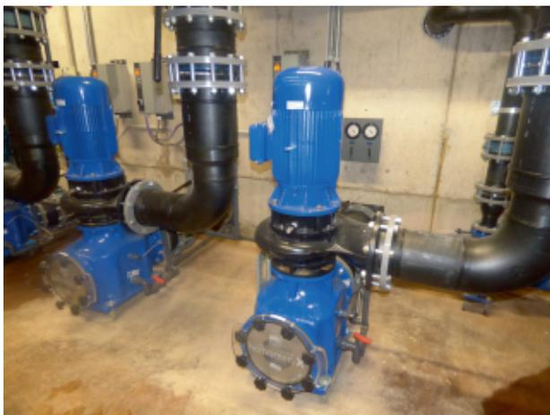
Umwälzpumpen pumpen das Wasser zu den einzelnen Stationen der Aufbereitung
