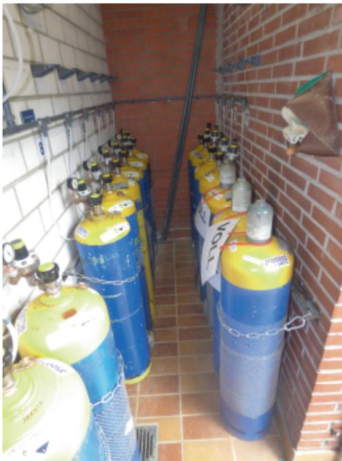
In einem eigenen Raum werden die Druckflaschen mit dem Chlorgas gelagert.
